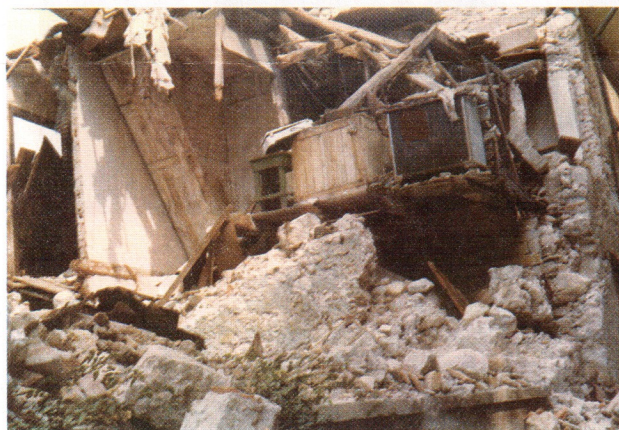
Immagini post terremoto a Gemona (foto di Tullio Mayer)
